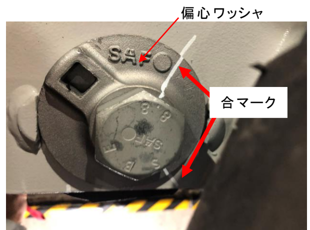
第 2 図. ピボット・ボルト部 マーキング
