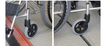
車イスや高齢者の方が負担を感じることなく駐車スペースに移動できるよう、床面の段差は20mm以下に、通路との隙間は20mm以下で設計されています。
