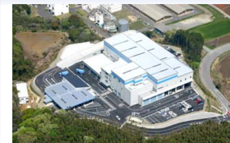
遠賀・中間リレーセンター
