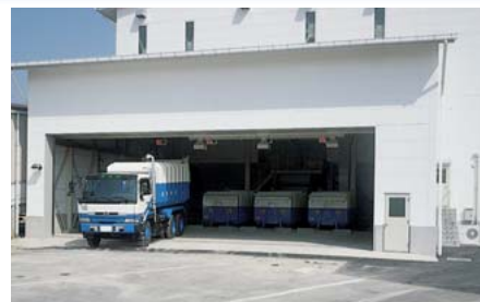
徳島市廃棄物運搬中継施設
