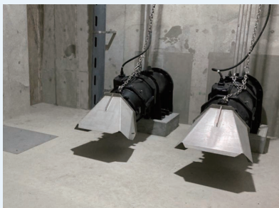
雨水貯留施設用大型横軸水中ポンプ (ポンプ口径500mm×出力11kW)
