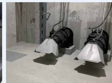
雨水貯留施設用大型横軸水中ポンプ
