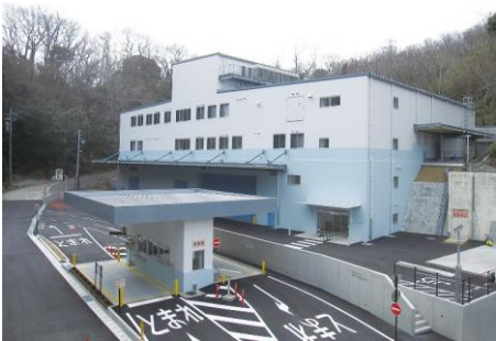
神奈川県中郡大磯町 大磯町美化センターリサイクルセンター (DBO案件)
