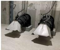
立軸槽外型ポンプ（水陸両用・耐水型）
