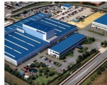
小野工場 (兵庫県小野市)
