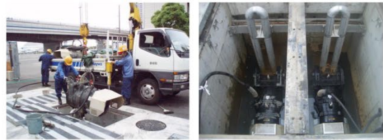
K市殿 雨水排水ポンプ (横軸軸流)
