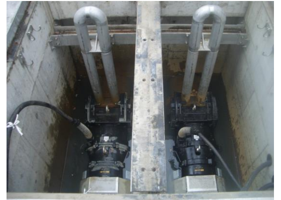
K市殿 雨水排水ポンプ（横軸軸流）
