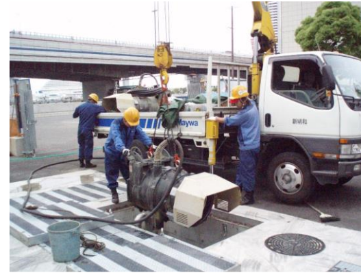
K市殿 雨水排水ポンプ（横軸軸流）
