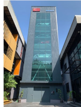
G-PARK社の敷地内に完成した ショールーム仕様の駐車設備 「G-PARK & ShinMaywa Tower」
