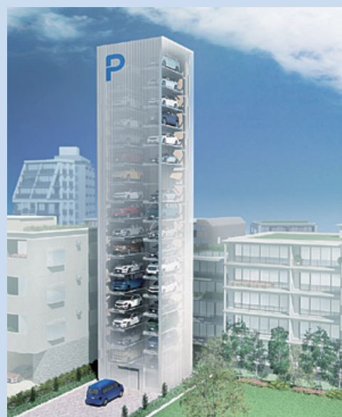
エレベータ方式駐車設備(イメージ)
