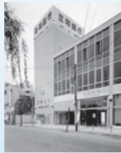
▲垂直循環方式立体駐車設備「ロータリパーク」
