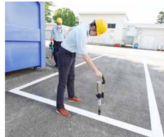
敷地内 駐車用の区画線施工
