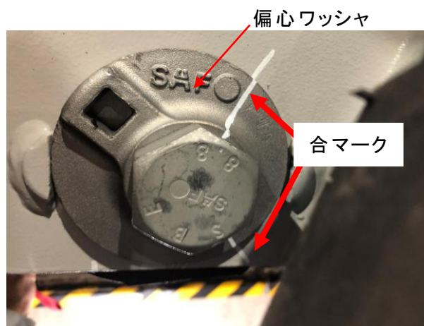
第2図. ピボット・ボルト部マーキング
