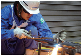
広島工場における競技（構造物鉄工）
