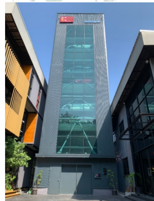
タイ・バンコクの協業先に納入した機械式駐車設備
