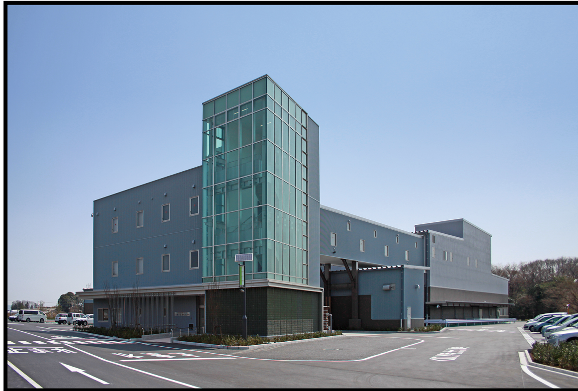
小山広域保健衛生組合 リサイクルセンター（栃木県のマテリアルリサイクル推進施設）
