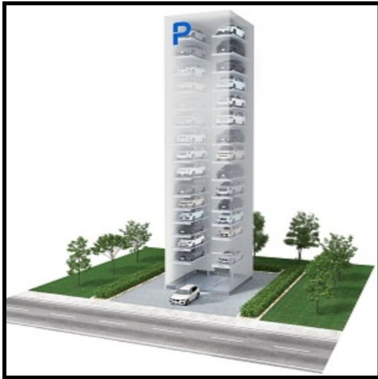
エレベータ方式駐車設備
